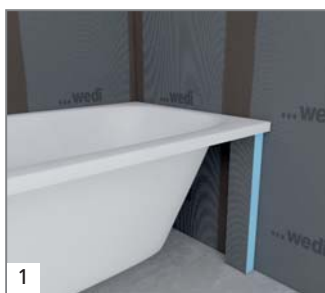
1 Montage des tasseaux de butée contre le mur.
