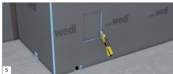
5 Le montage est aussi possible sans cadre de porte de visite. Si nécessaire, il est possible de réaliser à tout moment une trappe de visite.
