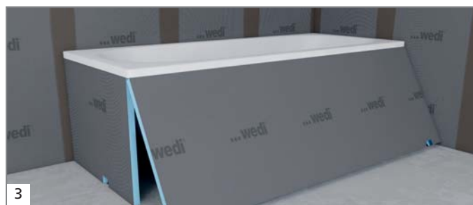
3 Mise en place du tablier de baignoire.
