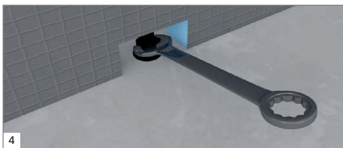
4 Réglage en hauteur des pieds avec une clé plate (ouverture 17) ou une clé à tubes jusqu'à ce que le wedi Bathboard soit bien calé sous le rebord de la baignoire.
