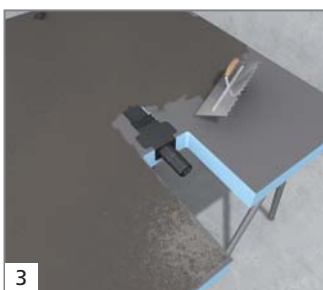
3 Remplir de colle à carrelage, les espaces vides du corps du siphon.
