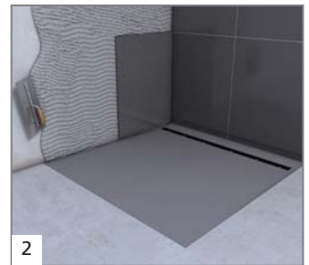
Pose du carrelage en laissant l'espace nécessaire pour la pose du profilé mural.
