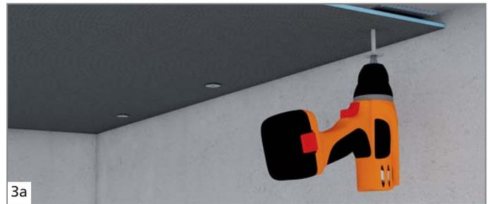
3a Visser le panneau de construction à l'aide de rondelles wedi *Tools*. Les chevilles sont positionnées en fonction des instructions pour ossatures bois et métal.
