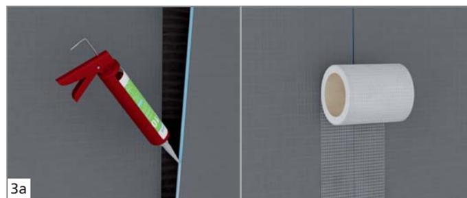
3a Dans les pièces humides, les jonctions peuvent être étanchées avec la colle polymère wedi 610. Pourvoir ensuite les jonctions entre les panneaux de construction avec la bande d'armature autocollante wedi Tools.
