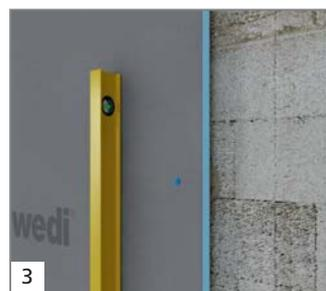
3 Plaquer le panneau contre le mur, taper légèrement et aligner avec une règle métallique. Ensuite, avec une perceuse de 8, percer des trous dans le mur au niveau des avant-trous à travers le panneau et les plots de mortier.
