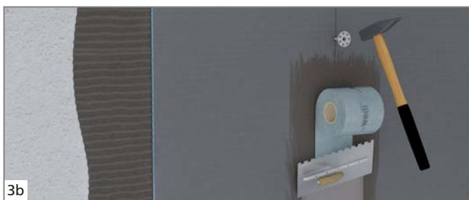
3b Les jonctions et percements peuvent alternativement être étanchés à l'aide de la bande d'étanchéité wedi Tools et de la colle à carrelage.
