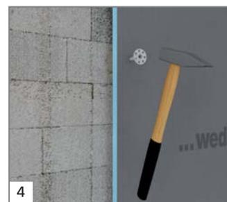
4 Placer les chevilles métalliques wedi *Tools* à travers les plots de mortier et les trous pré-perçés et n'enfoncer entièrement que lorsque les plots de mortier ont durci.
