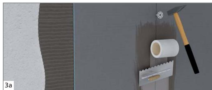
3a Appliquer la colle à carrelage en plein sur les panneaux et les aligner. Enfoncer les chevilles métalliques wedi Tools pour la fixation. 8 chevilles métalliques wedi Tools par panneau (5 par m<sup>2</sup>). Pourvoir toutes les jonctions entre les panneaux avec la colle à carrelage et poser la bande d'armature wedi Tools. En alternative, il est également possible d'utiliser la bande d'armature autocollante wedi Tools.
