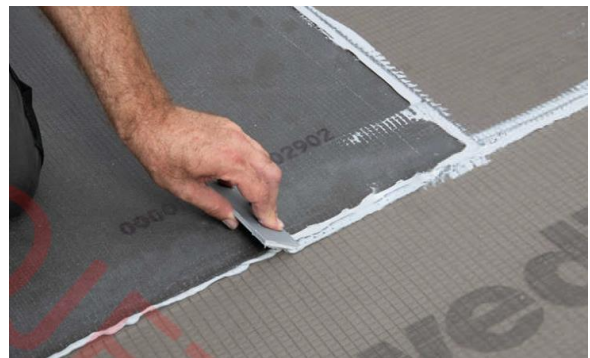
Fig 19 : joints entre panneaux et entre panneaux et receveur wedi Fundo avec wedi 610
