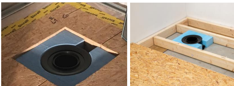
Figure 12 : siphon wedi Fundo positionné dans sa cale
