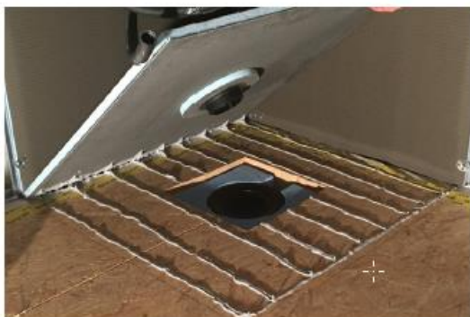
Figure 13 : collage du receveur Fundo Ligno plus à la colle wedi 610 ( lignes espacées de 10 cm )
