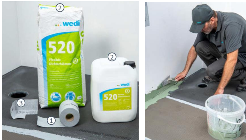
Fig 20 : Utilisation des angles (3) et bande étanche (1) wedi Tools collés au SEL bi composant wedi 520 ( 2) au périmètre de la SDE
