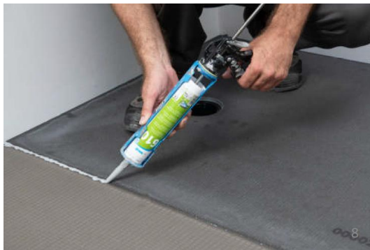
Fig 19 : joints entre panneaux et entre panneaux et receveur wedi Fundo avec wedi 610
