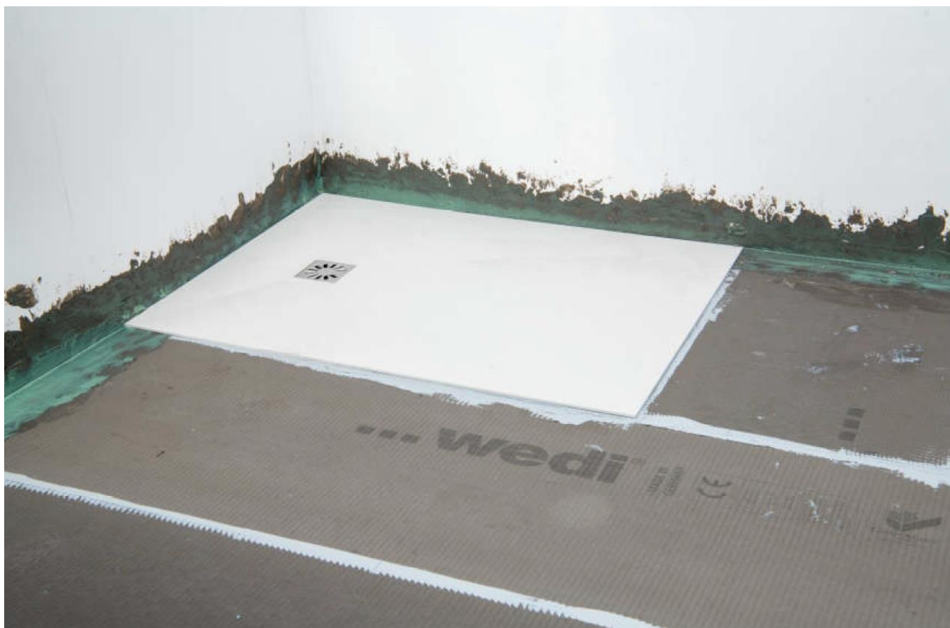
Figure 24 : Vue de l'espace de douche revêtu Fundo Top , avec panneaux wedi en partie courante de salle d'eau, et raccords et pontages étanches avant carrelage :
