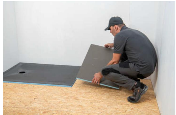
Fig 18 : Collage des panneaux wedi au support bois avec la colle wedi 610 ( lignes tous les 10 cm)
