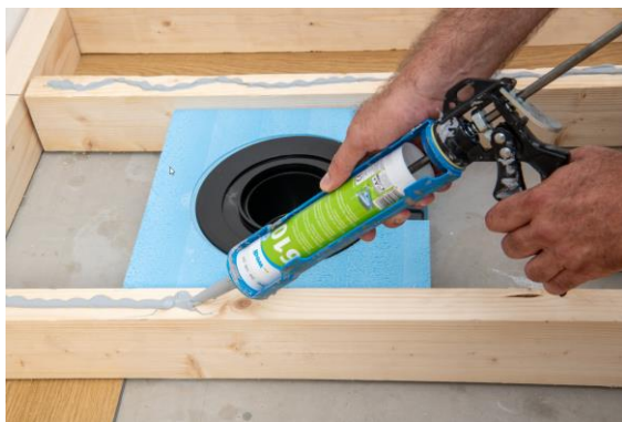
Figure 14 : collage du receveur Fundo Primo directement sur solives à la colle wedi 610
