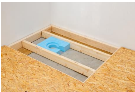
Figure 11 : mise en place de la cale de siphon wedi Fundo
