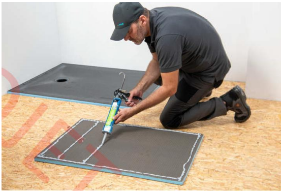
Fig 18 : Collage des panneaux wedi au support bois avec la colle wedi 610 ( lignes tous les 10 cm)
