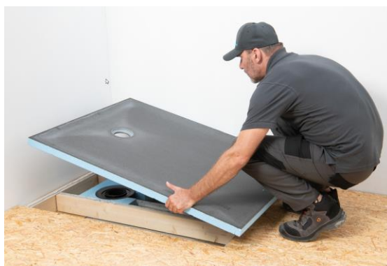
Figure 14 : collage du receveur Fundo Primo directement sur solives à la colle wedi 610
