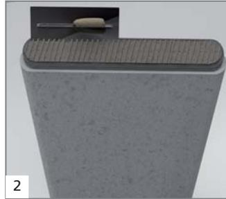
2 Enduire les surfaces de contact de colle à carrelage de type C2.
