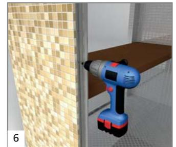
6 À l'aide de vis autotaraudeuses, fixer la feuillure de porte au centre de l'embrasure. Attention : ne pas serrer trop les vis autotaraudeuses.
