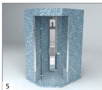
La cabine complète peut maintenant être carrelée et scellée. Ensuite, installer les éléments vitrés.
