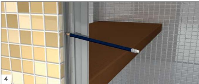
4 Positionner la feuillure de porte au centre de l'embrasure intérieure opposée à l'élément vitré fixe pour pouvoir marquer les trous à percer dans le carrelage.
