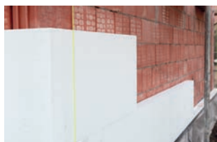
Isolation extérieure avec enduit de finition
