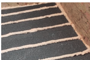
Isolation de plancher de grenier
