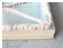
Collage de panneaux d'isolation
