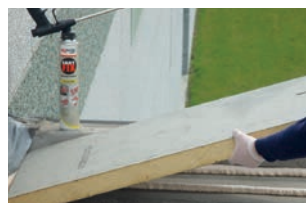
Isolation de toiture plate
