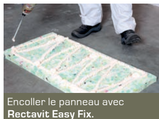
Attendre min. 5 min jusqu'à ce que la colle soit prête.
