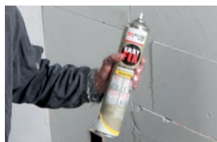
4. Secouer fermement la bombe 30 fois ou durant 30 sec.
