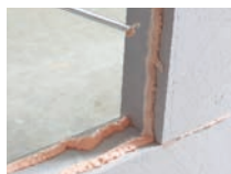
Collage de béton cellulaire
