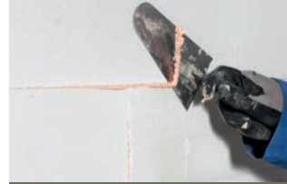
Après 1h complète de durcissement, la finition peut commencer
