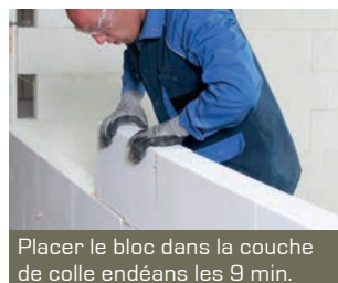
Les blocs d'assise peuvent être jointoyés verticalement
