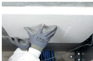
Isolation de plafond
