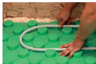
Isolation de chauffage par le sol
