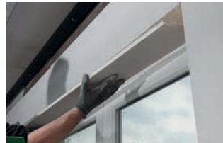
6. Placer la partie supérieure de l'ébrasement
