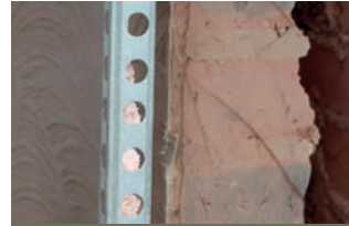
Fixation de profilés pour plâtre
