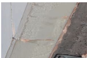
Isolation intérieure avec plaque de plâtre
