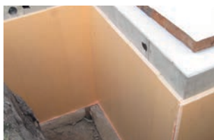
Terminer les connexions dans les coins.
