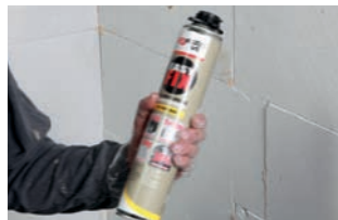
1. Secouer fermement la bombe 30 fois ou durant 30 sec.
