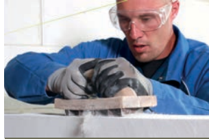
Raboter où nécessaire
