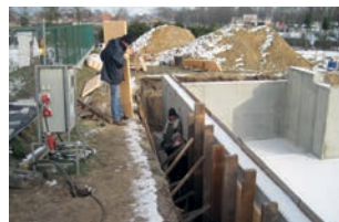
Appliquer les panneaux à leur place.
