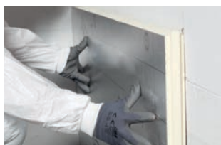
Isolation de mur intérieur
