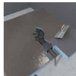
3/ Remplir les espaces vides du corps de siphon, avec de la colle à carrelage.
