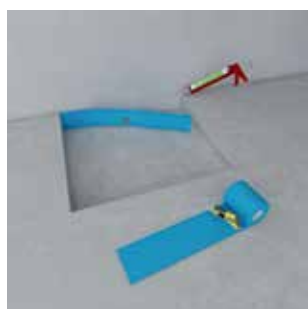
2/ Pour une désolidarisation acoustique, poser la bande de rive et la coller avec wedi 610.
