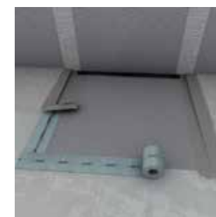
12/ Réaliser l'étanchéité des jonctions avec le kit d'étanchéité wedi Fundo.
