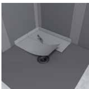
8/ Recouper la natte d'étanchéité en conservant un chevauchement d'environ 5 cm.
