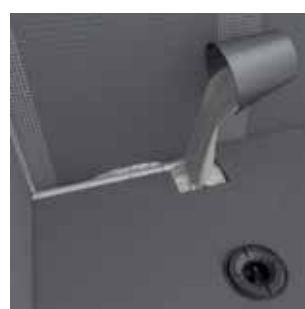
6/ Raccorder la tuyauterie et combler l'espace vide avec un mortier de scellement.
