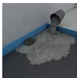
6/ Combler la réservation avec du mortier chape.
