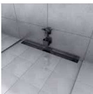
15/ Installer la tasse du siphon et l'élément anti-odeurs.
