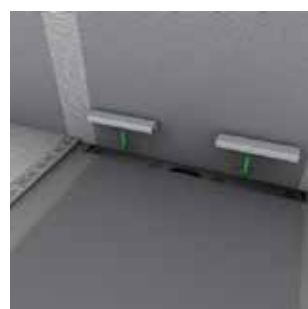
13/ Les guides fournis permettent de garantir la bonne distance entre le canal d'écoulement et le carrelage.
