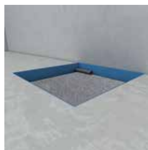
3/ Pour une réduction acoustique des bruits d'impact, découper et poser Nonstep ProS.
