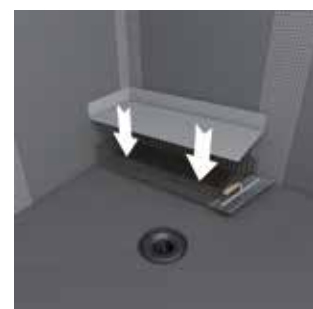
9/ Coller la natte d'étanchéité avec la colle à carrelage.
