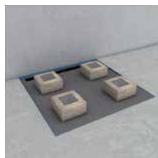
10/ Lester le receveur avec des cartons de carrelage (4 x 15 kgs).
