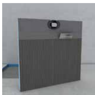
9/ Encoller la sous-face du receveur de colle à carrelage de type C2 et le coller sur le support.
